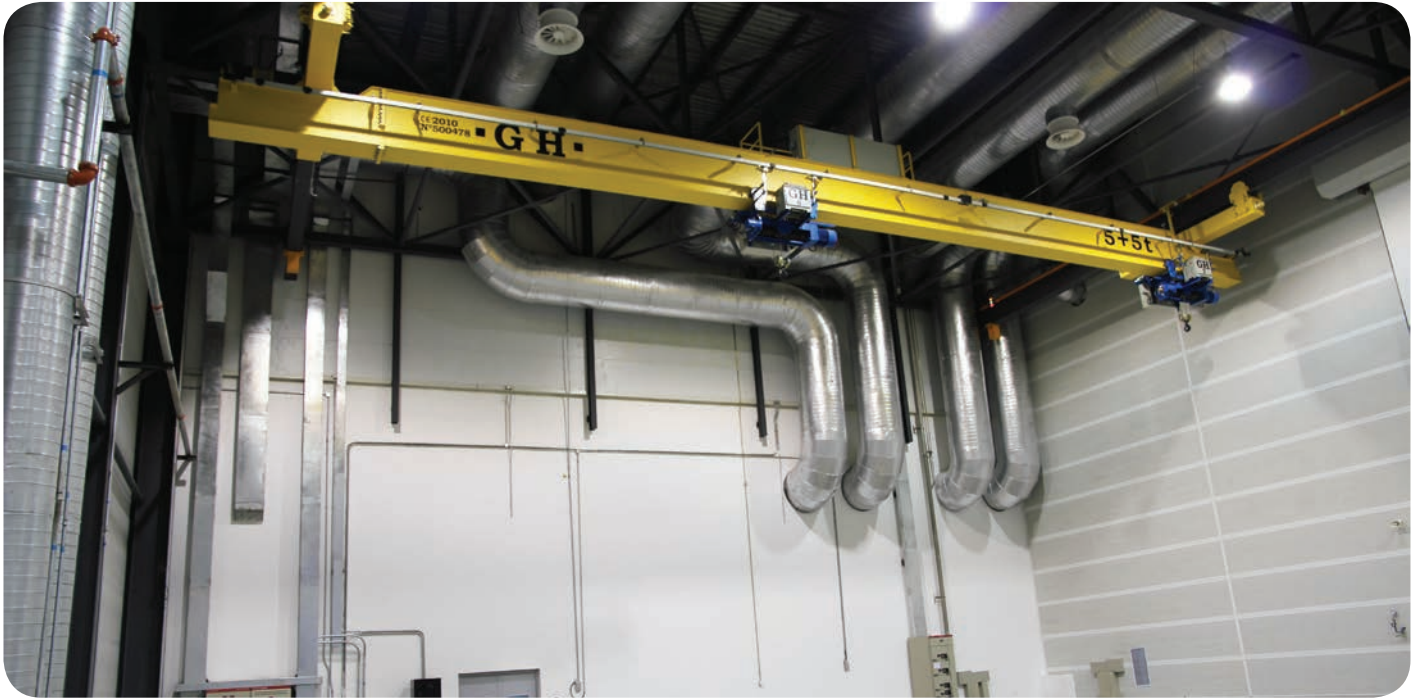
SUWNICA JEDNODŹWIGAROWA: UDŹWIG DO 20+20T.
