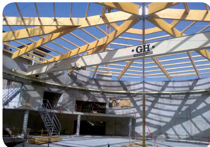
PONTE ROLANTE CIRCULAR
